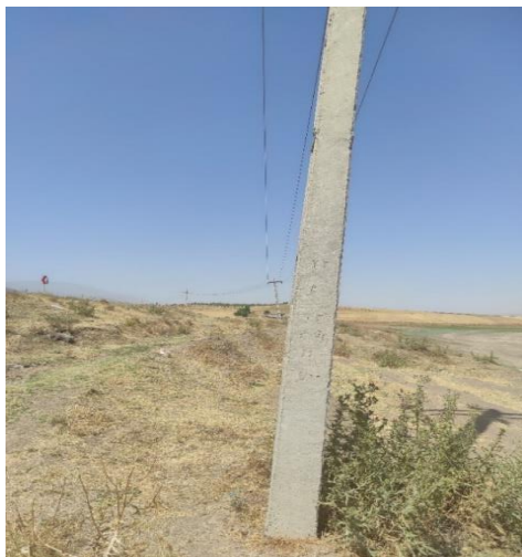
شکل ۱۶: کج شدن پایه‌ها که احتمال شکست آن‌ها در طوفان شدید وجود دارد
