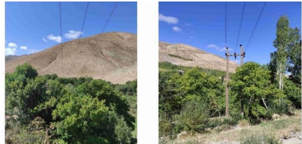
شکل ۱۲: عدم رعایت حریم توسط درختان گردو در مسیر روستاهای خمّس، اسکستان، اسبو و درّو
