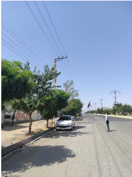
شکل ۱۴: استفاده از آرایش نامناسب و اسپین طولانی
