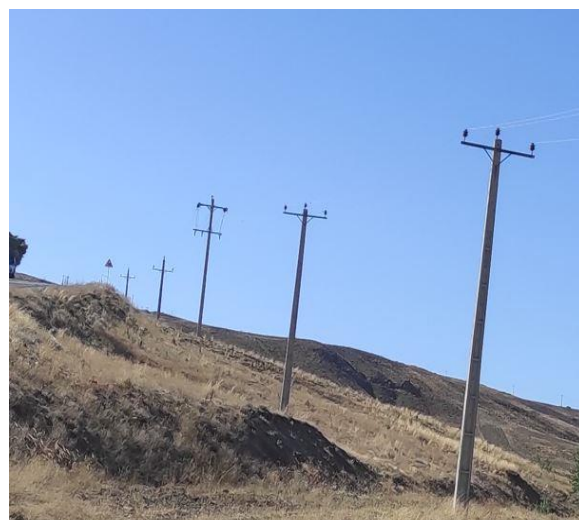
شکل ۱۱: استفاده از کراس‌آرم نوع L که در آن نبشی بصورت غیراستاندارد و بالاتر نصب شده است.
