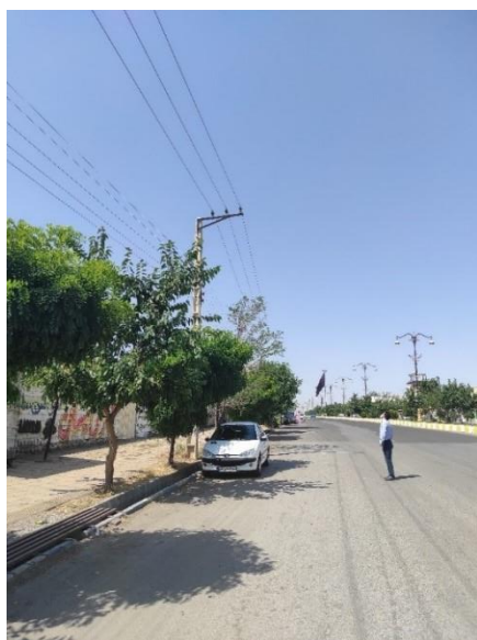
شکل ۱۴: استفاده از آرایش نامناسب و اسپین طولانی
