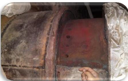
شکل (۱۴): نازل‌های مرکزی مشعل و اجزاء آن
