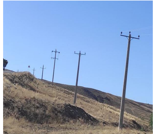
شکل ۱۱: استفاده از کراس‌آرم نوع L که در آن نبشی بصورت غیراستاندارد و بالاتر نصب شده است.
